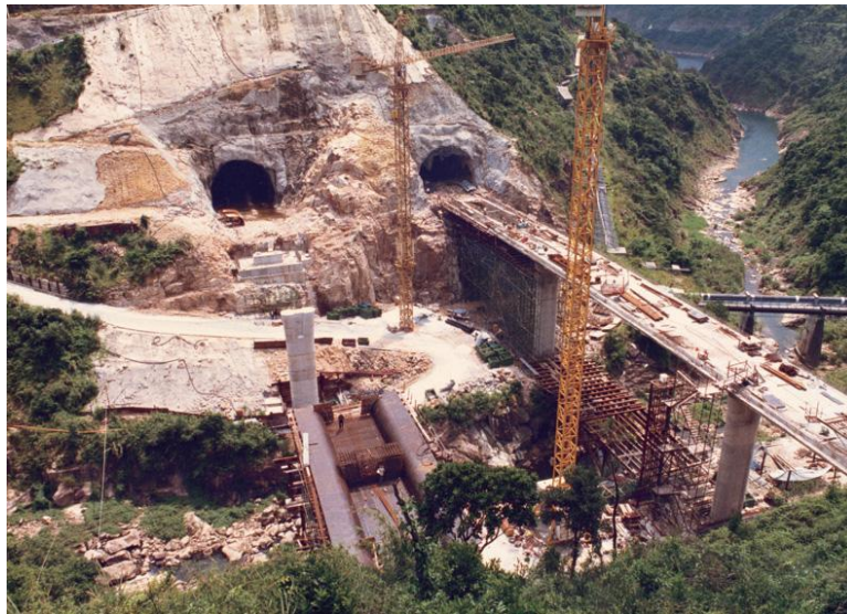
圖三：城門隧道興建時於郊野公園範圍內的地盤情況 11
