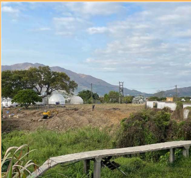
位於錦田一個正在興建中的私人營地 A private campsite in Kam Tin under construction
